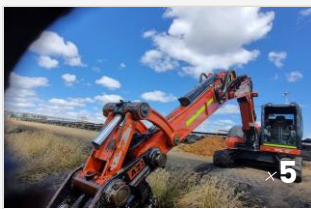
i Excavators SK210LC 20 t · SK140 16 t · Kubota 8 t and 5 t · Hitachi 5 t.
